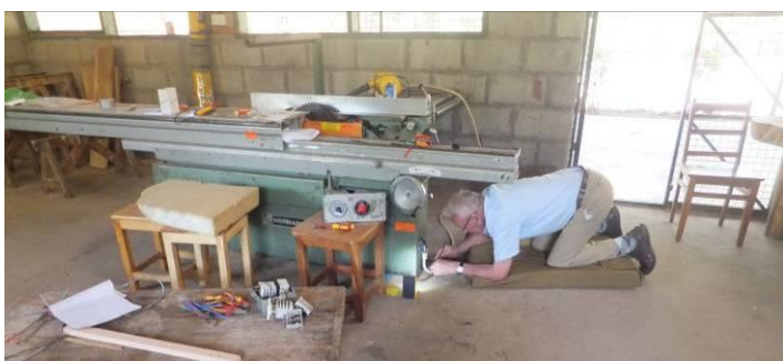
Wout Hanegraaf vervangt een schakelaar / foto Ton SWU
